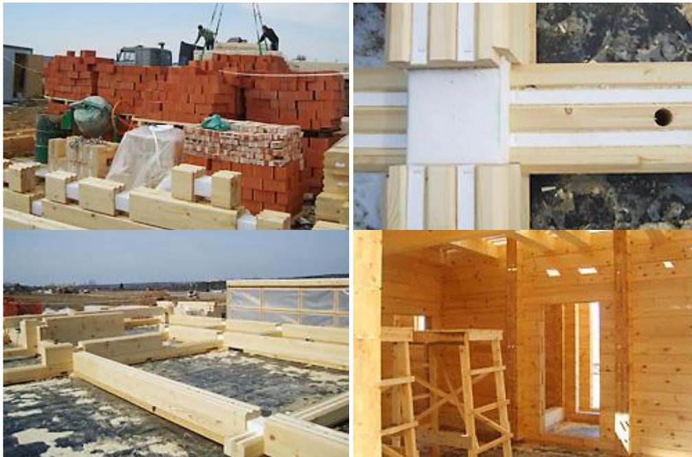
Каркас дома собирается из брусев, заготовленных для каждой стены перегородки, согласно проекту дома.
