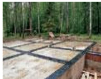
*Выведение "нуля", гидроизоляция бетонной стяжки*
