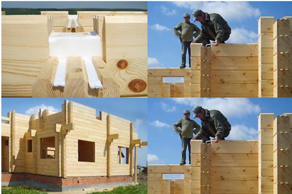
По просмоленной доске укладывается минераловатная плита (ГОСТ 21880-94 или ГОСТ 22950-95) или войлок, а на них шунтируется первый венец, который был подготовлен для посадки на анкерные болты.
